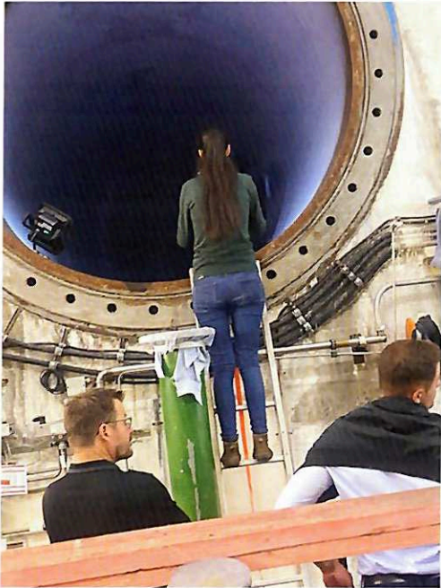
Ein begehrtes Fotomotiv: Blick vom ausgebauten Kugelschieber in das Spiralgehäuse der Turbine (hier von Bauingenieurin Maria Gorfer).
