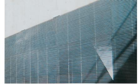
**VOR DEM EINLAUFBEREICH** zu den beiden Turbinen wurde ein Horizontalrechen eingesetzt. Er ist 24 Meter breit und 3,5 Meter hoch.
